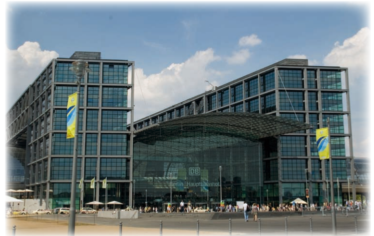
Abb.: Brandschutz in den DB-Bahnhöfen in Berlin – hier der Hauptbahnhof – von den Experten der hhpberlin. Quelle: hhpberlin
